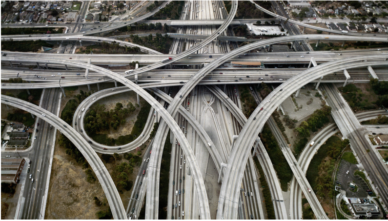
Doc1 - Échangeur d'autoroute à Los Angeles, USA
